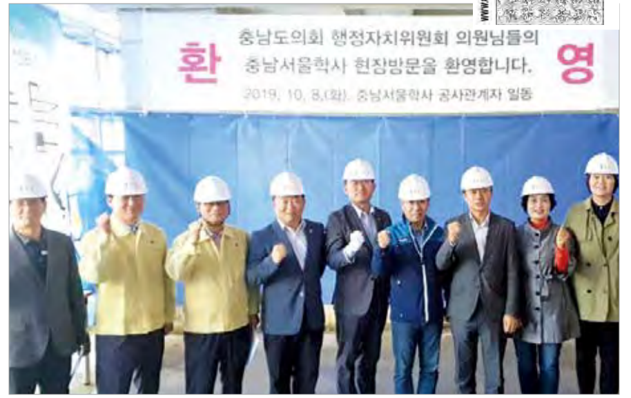
행정자치위원회 소속 의원들은 지난 8일 충남서울학사 공사현장을 찾아 관계자들을 격려하고 공사 진행 현황을 점검했다.
