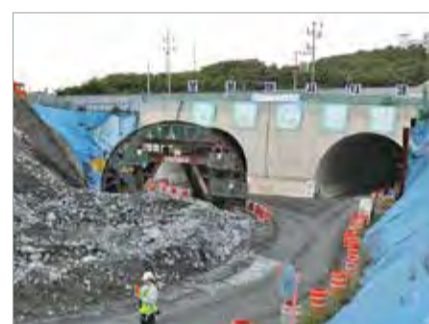
보령해저터널 공사현장 입구
